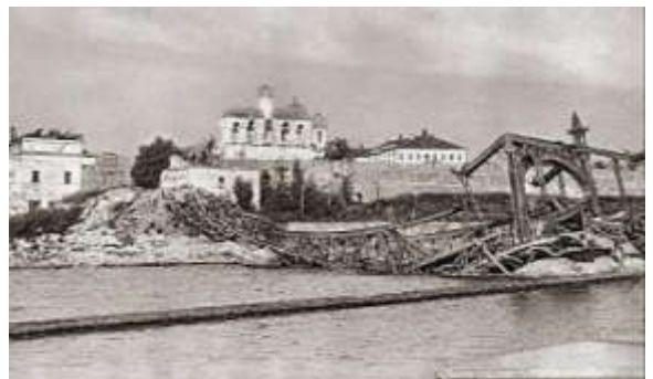
Разрушенный мост через реку Волхов
